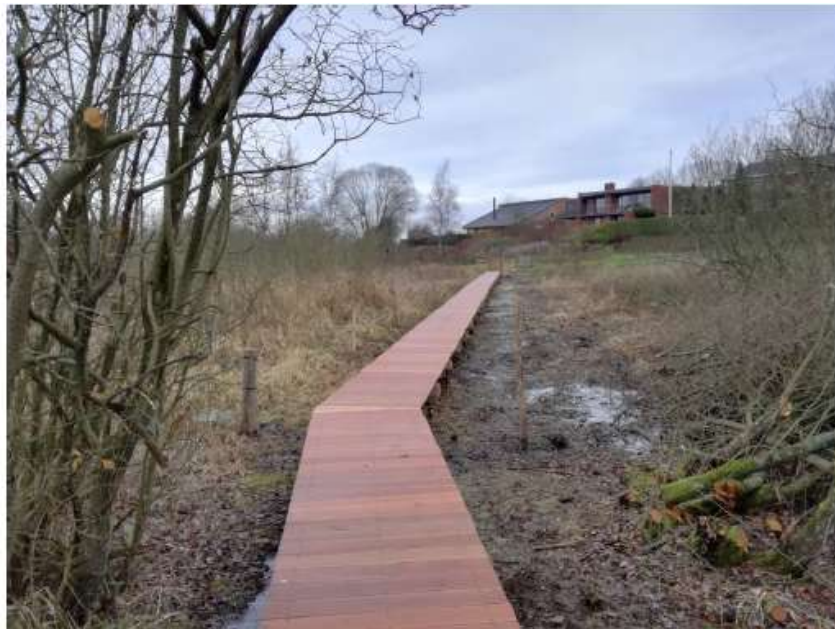
Figur 3: Figur 2: broen opføres som på foto - dog med en bredde på 135 i stedet for 120 og med 4 van-ger i stedet for 3.
